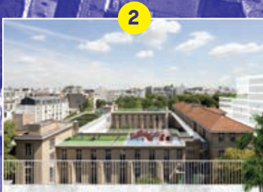
Les toitures, espaces d'agriculture urbaine
