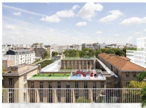
Les toitures, espaces d'agriculture urbaine
