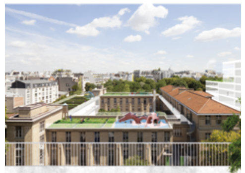
Les toitures, espaces d'agriculture urbaine
