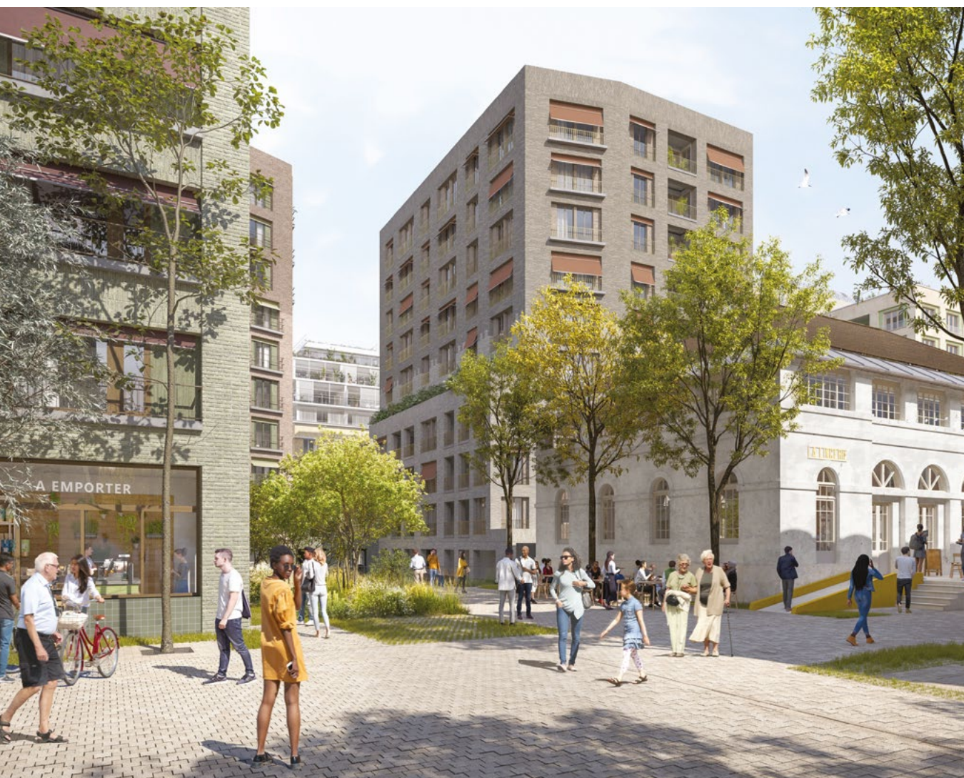
↑ Le bâtiment Chaufferie et la Lingerie.
