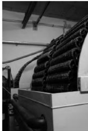
Système de filtration mécanique
